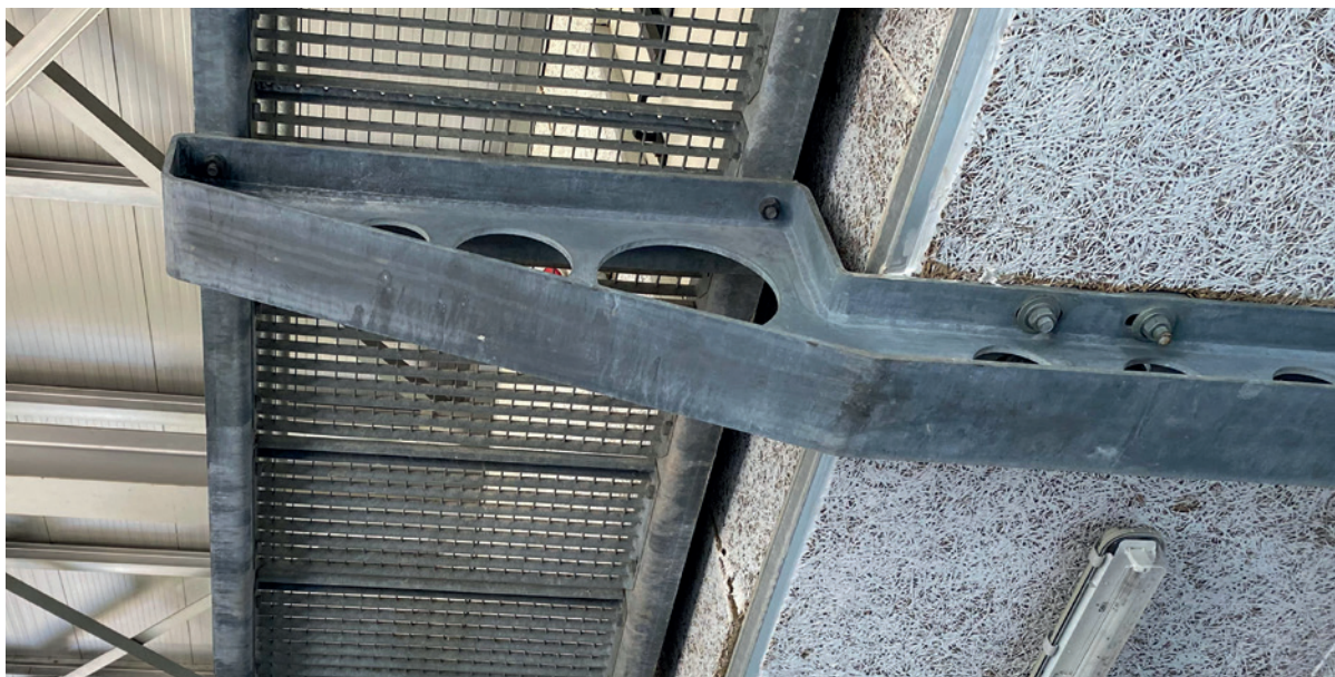
▲ Montage von Kabeltragsystemen und schwerer Stahlkonstruktionen
