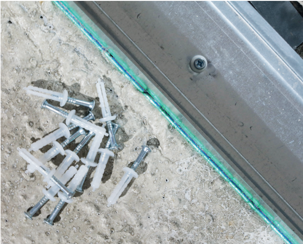
▲ Montage von Profilen für Gipskartonkonstruktionen
