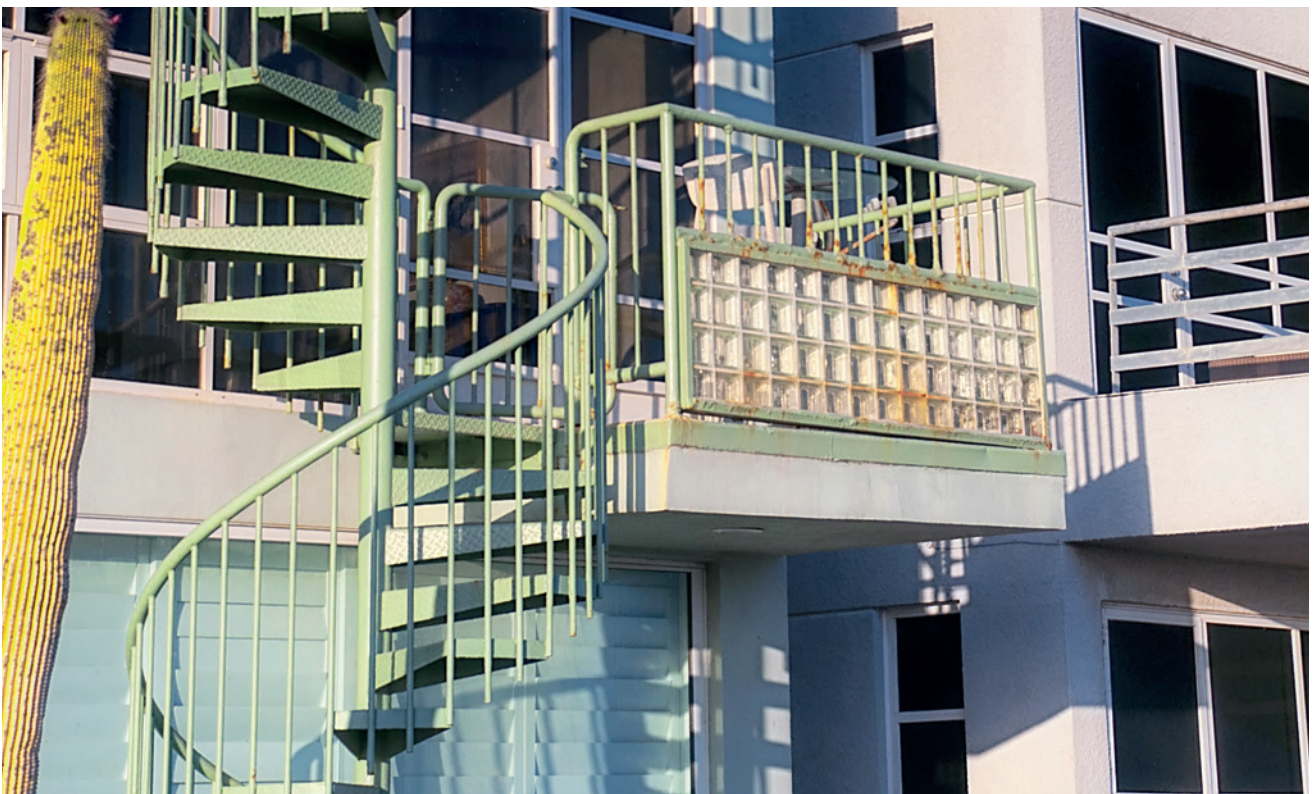
▲ Montage von Treppen und Geländern
