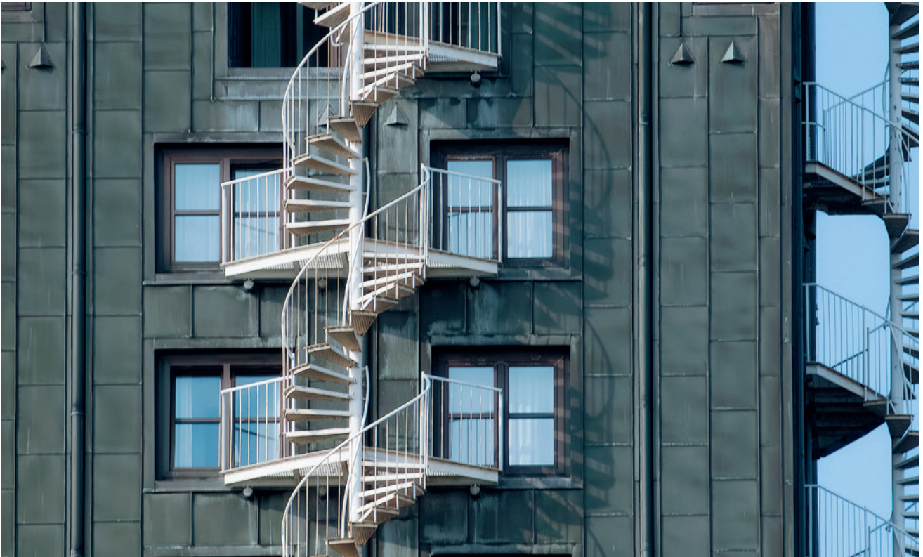
▲ Montage von Fluchttreppen
