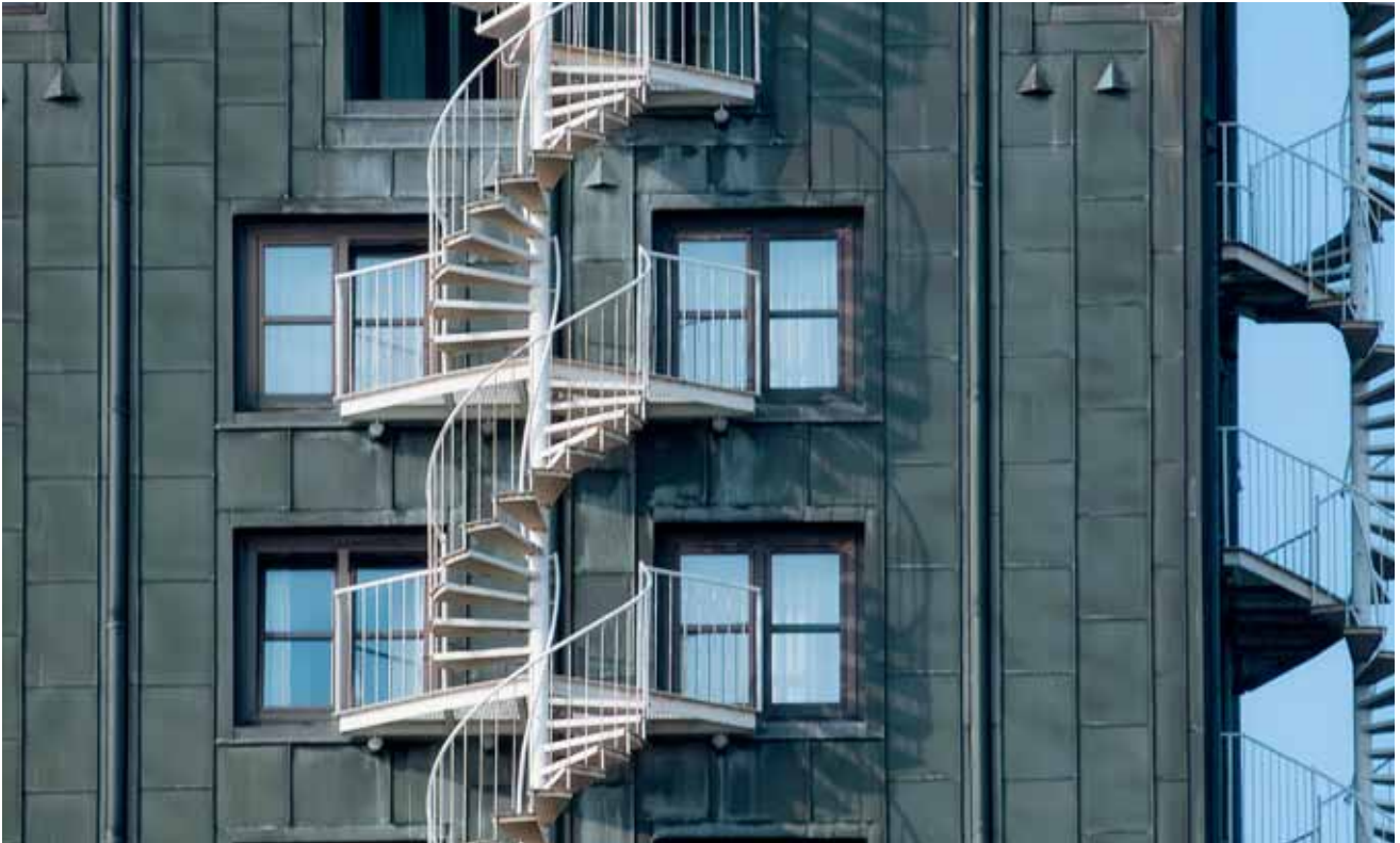
▲ Installation d'escaliers de secours
