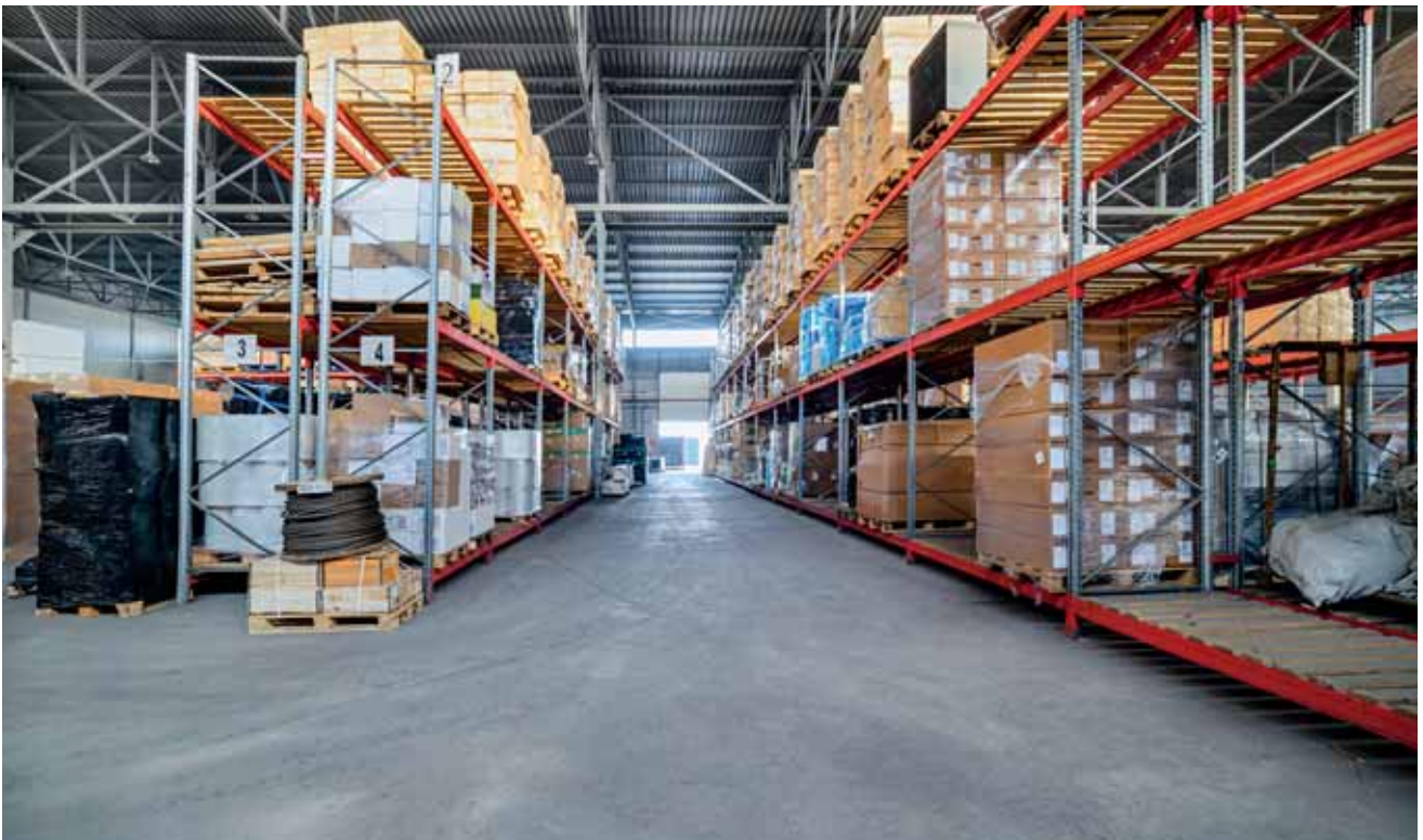
▲ Installation de rayonnages industriels
