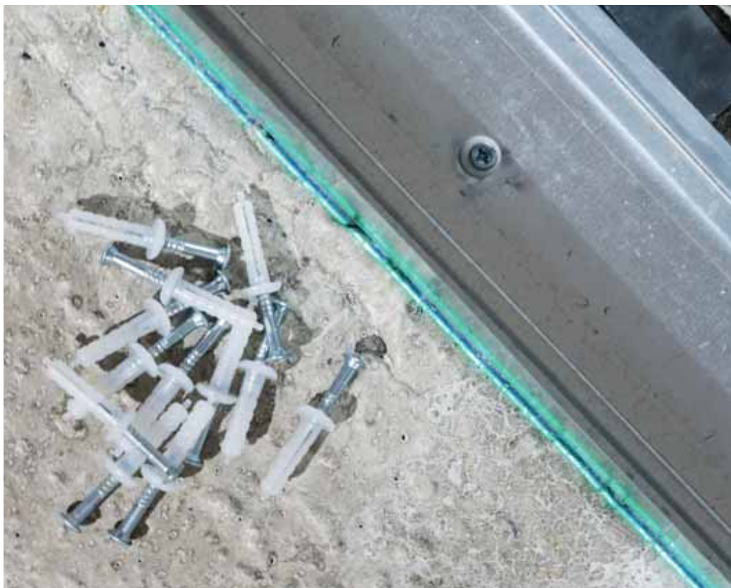
▲ Pose de profilés pour une structure en plaques de plâtre
