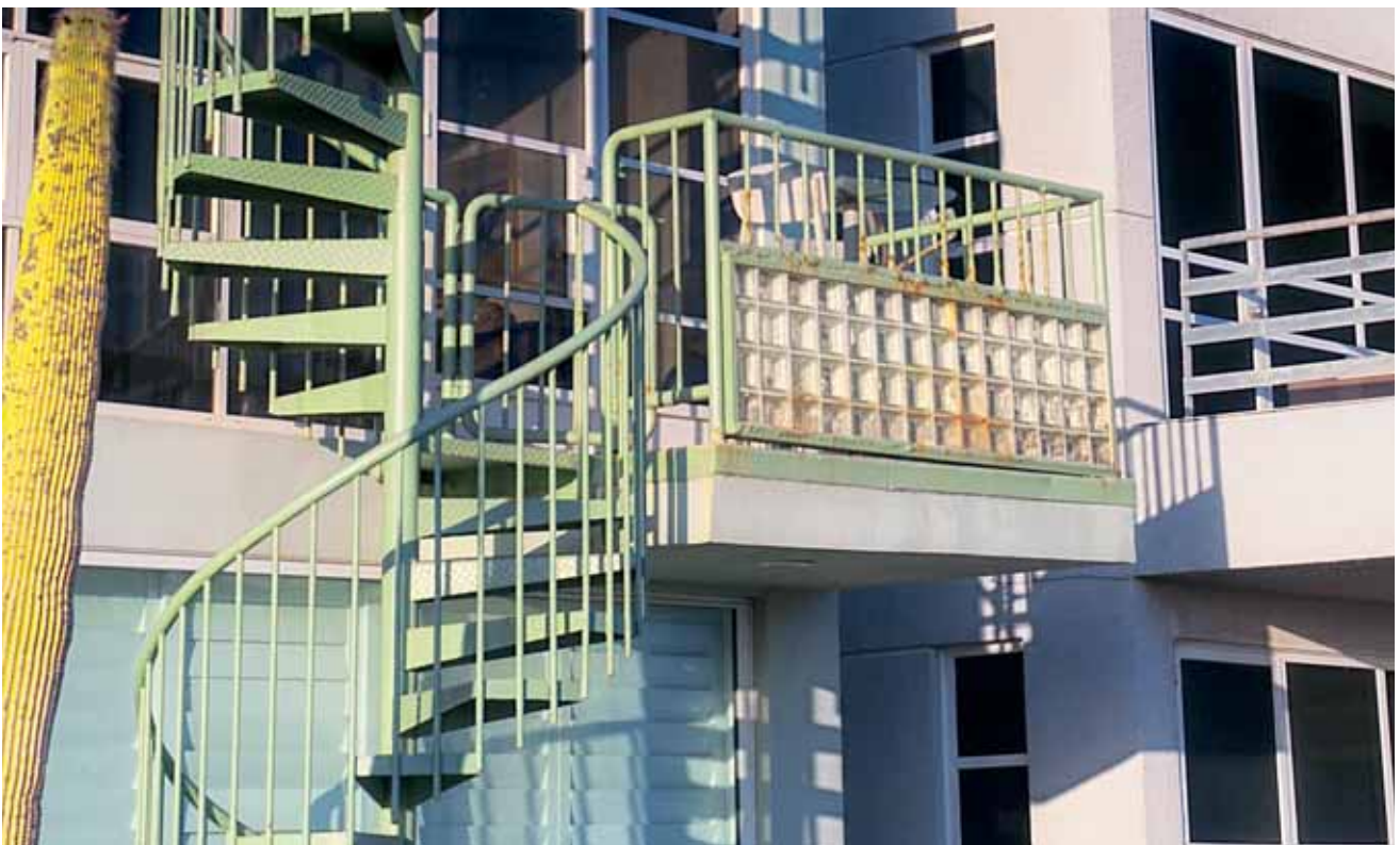
▲ Installation d'escaliers et de garde-corps
