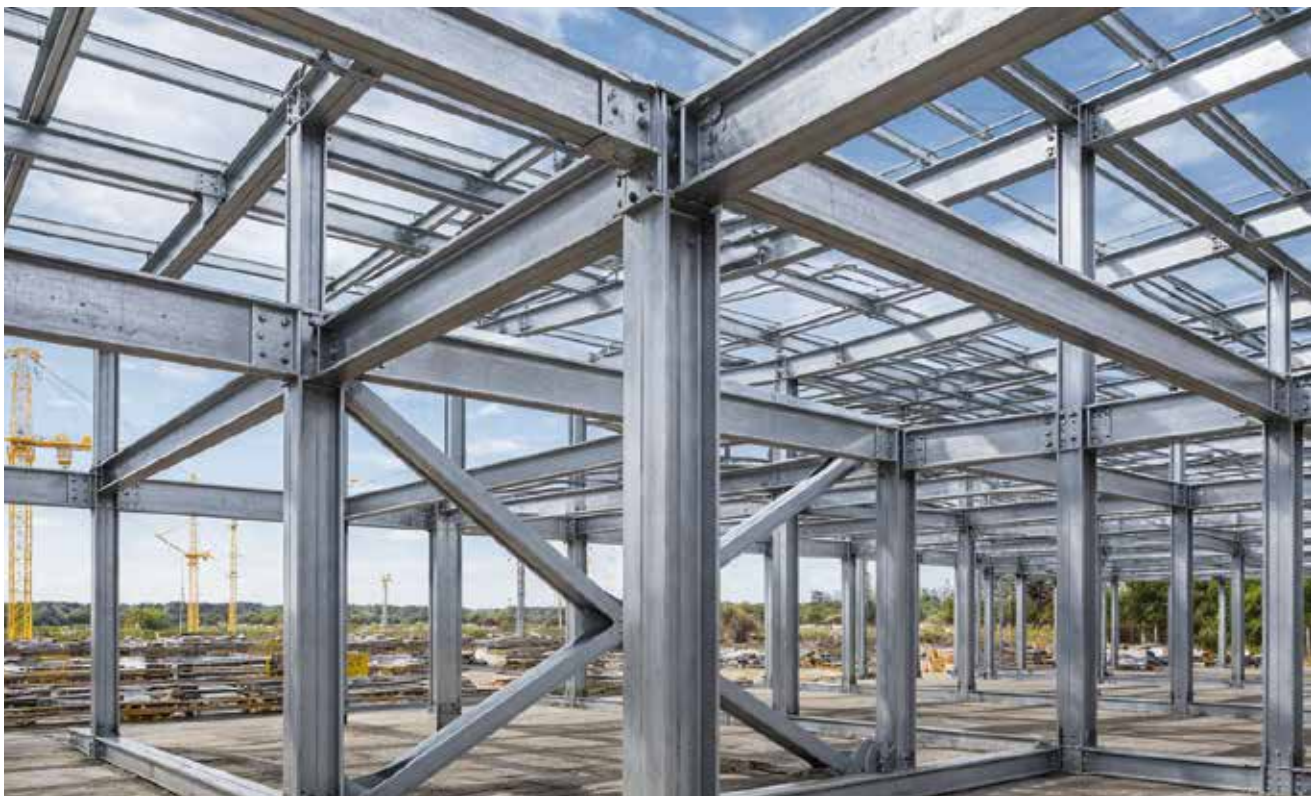
▲ Utilizzo su travi d'acciaio e carpenteria metallica
