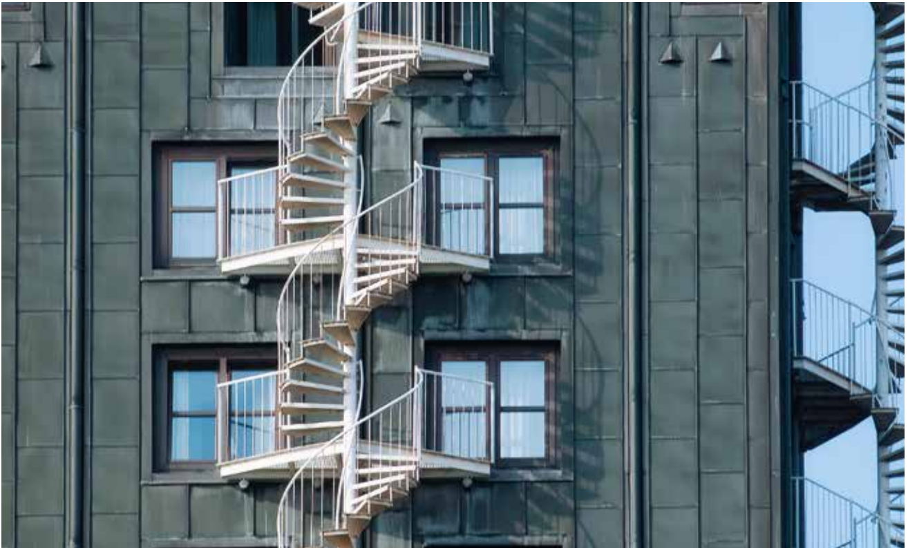
▲ Installazione di scale antincendio
