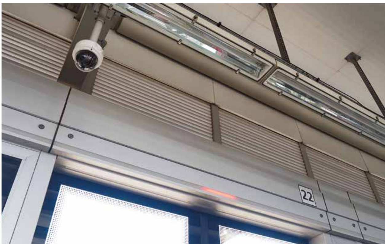
▲ Installazione canaline industriali
