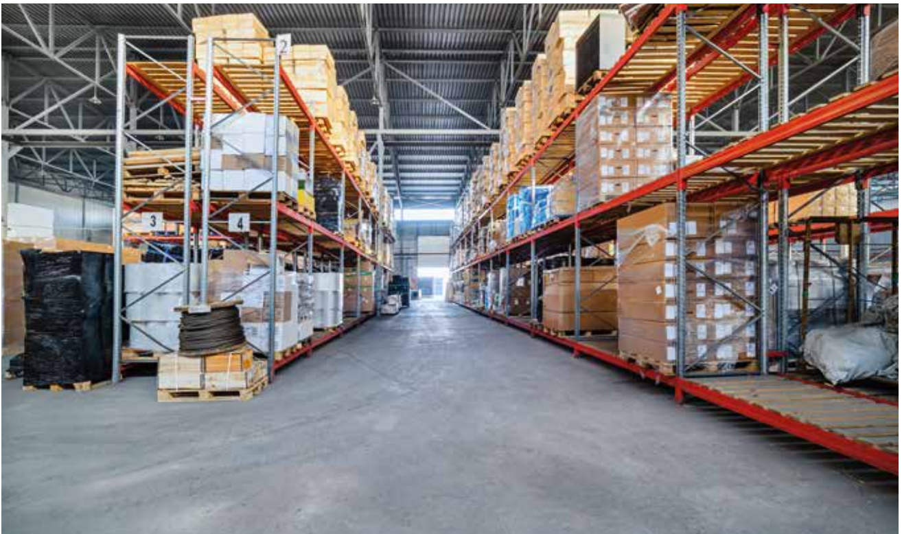
▲ Installazione di scaffalature industriali
