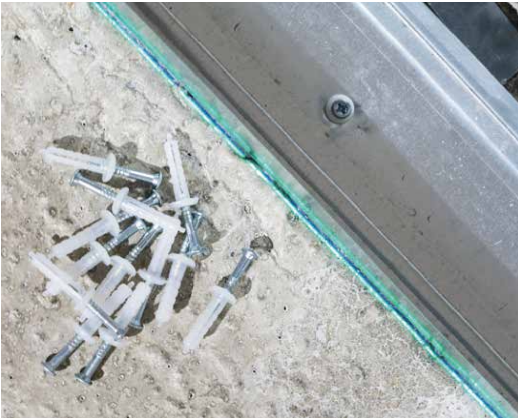
▲ Installazioni profili per struttura in cartongesso
