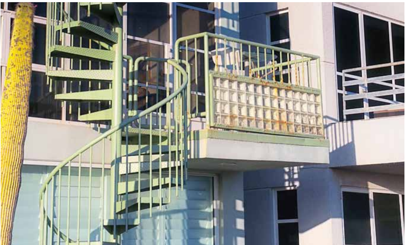
▲ Installazione di scale e parapetti
