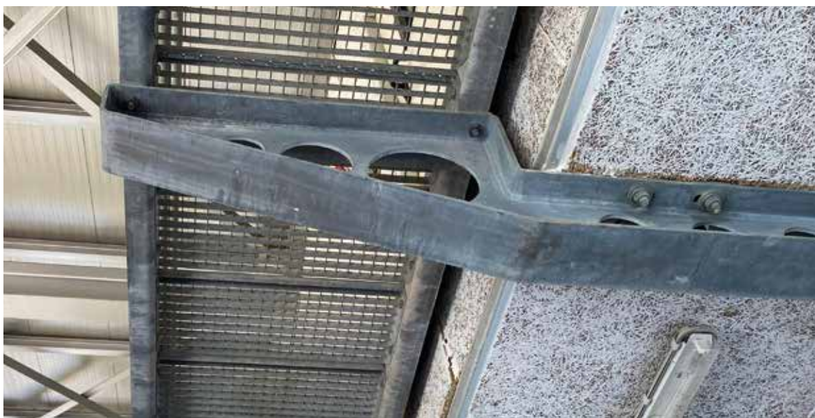
▲ Installazione di strutture porta cavi e carpenteria pesante
